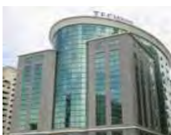
Wisma TechnipFMC (b)
