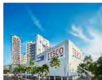
TESCO Building Penang (d)
